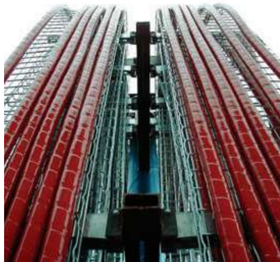
Ejemplo de mayor necesidad de espacio con la distribución con bandejas de cables.
