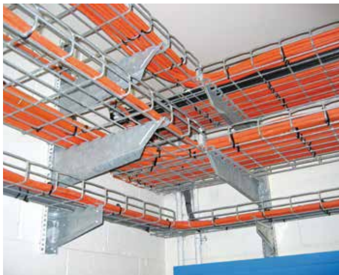
Ejemplo de espacio utilizado por un sistema de charola y cable.
