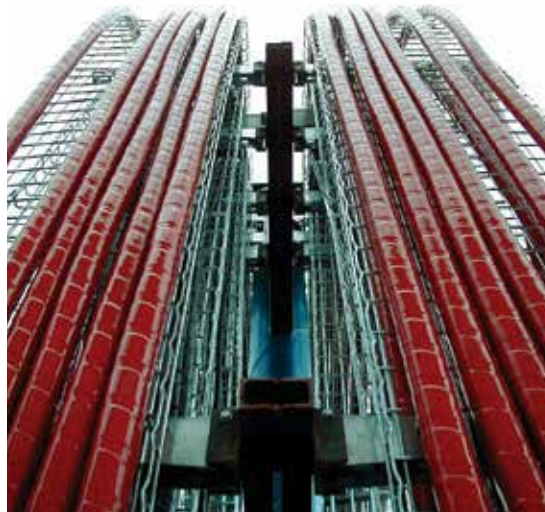
Ejemplo de mayor necesidad de espacio con la distribución a un sistema de charola y cable.
