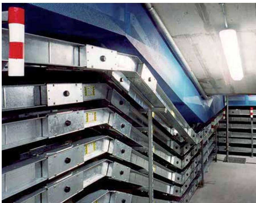
Ejemplo de distribución de alta potencia
